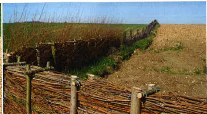
La construction d'une fascine, un aménagement pris en charge à 80 % par les institutionnels (cynégétique et agence de l'eau). La fascine se révèle très efficace dans la lutte contre la formation de ravines, un phénomène qui sévit en Seine-Maritime.
